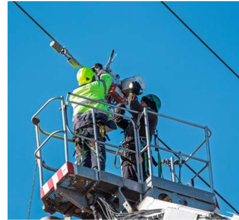
A berendezést két hajtógörgővel kellett rögzíteni a feszültségmentesített távvezetékre Fotó: MVM XPert Zrt., Réti Dóra
