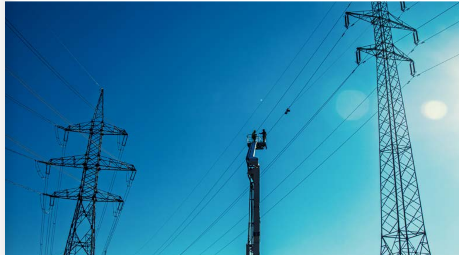
A távirányítású készülék a távvezeték mentén húzta át az előkötelet Fotó: MVM XPert Zrt., Réti Dóra
